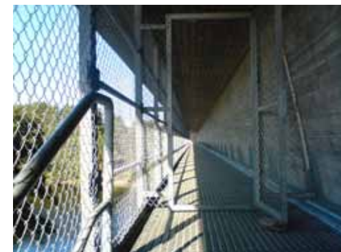
Järnvägsbron över Lagan har en inbyggd gångpassage.
