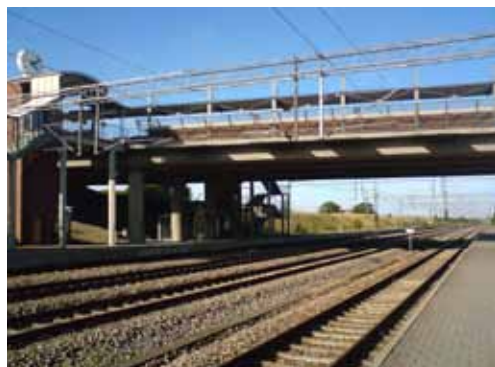
Järnvägen går i skärning vid Laholms station.
