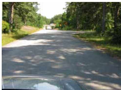
Tunnel under motorväg E6.
