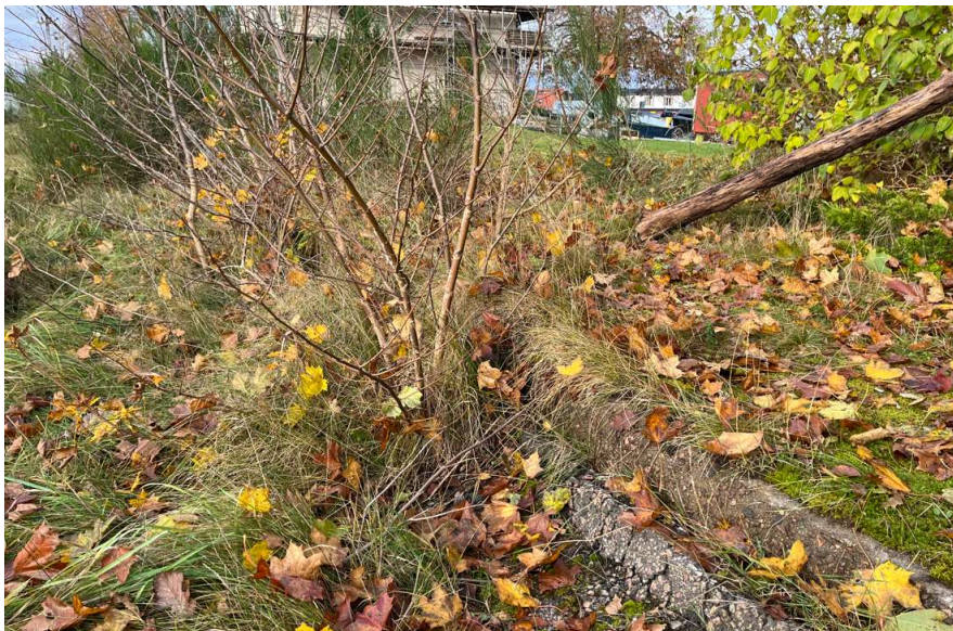
Figur 2. Kvarlämnade byggnadsrester (kantsten). (AFRY AB, 2023).
