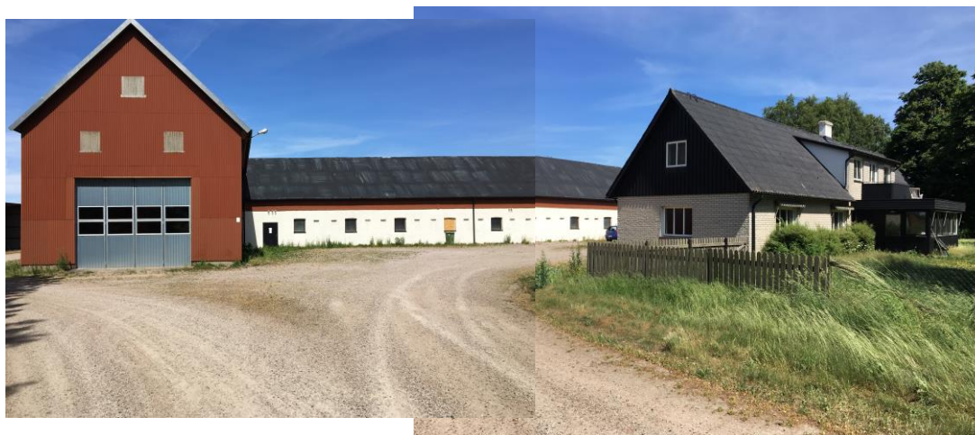
Foton av bostadshus och delar av bruksbyggnaderna som är sammanbyggda.
