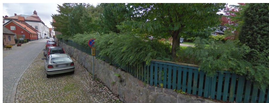
Bilder på murens utseende utmed med Gamlebygatan.
